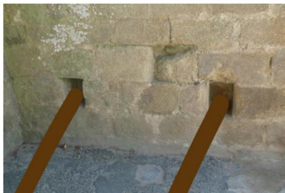
Deux poutres en bois, encastrées dans les trous carrés du mur, gênaient le passage des attaquants à cheval.
