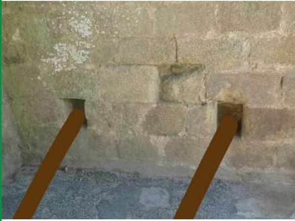
« Au niveau du sol, quatre trous permettent d'encaster des poutres en bois en travers du passage. Cette installation sert à déséquilibrer les chevaux des adversaires et à ralentir le passage des attaquants à pieds. »
