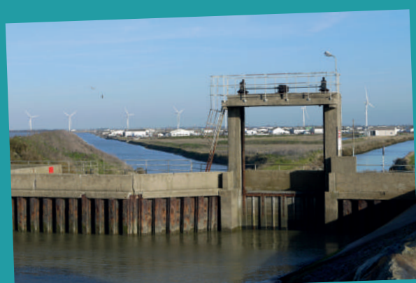
Vue sur le polder ostréicole
