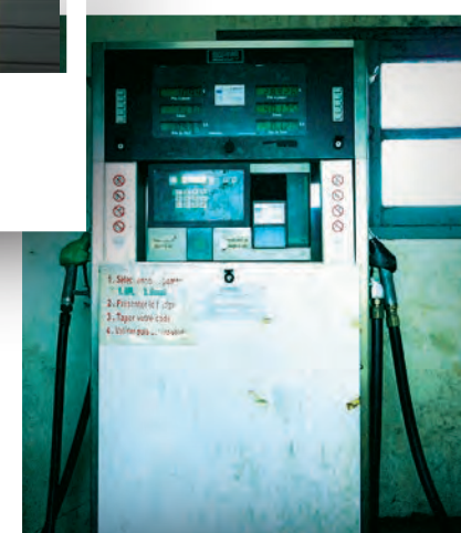
Le poste à gasoil
