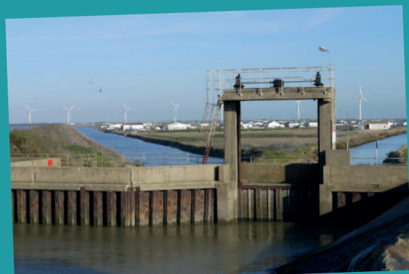
Vue sur le polder ostréicole
