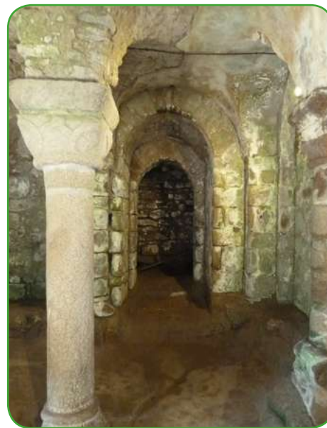
Ancien accès de la crypte
